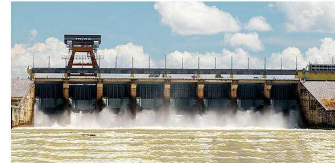
Nhà máy thủy điện Trị An
